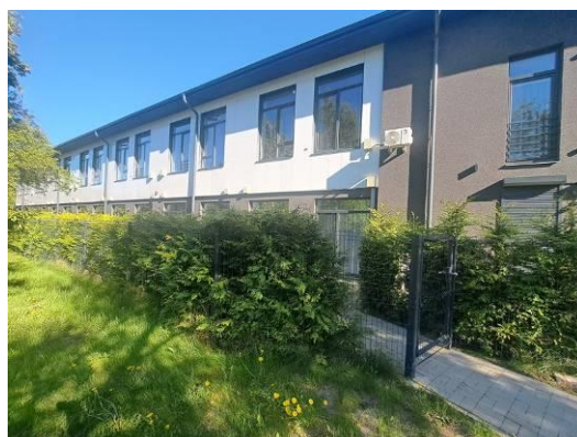
Atsevišķie ieejas vārtiņi lietošanā esošajā zemes gabala daļā / telpu logi
